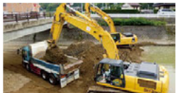
井戸川の災害復旧の様子(熊野市)
