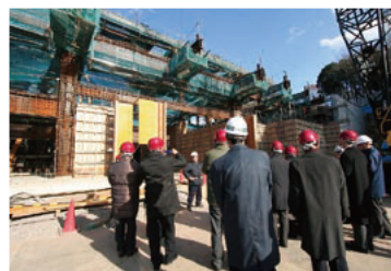
建設中の新県立博物館(津市)
