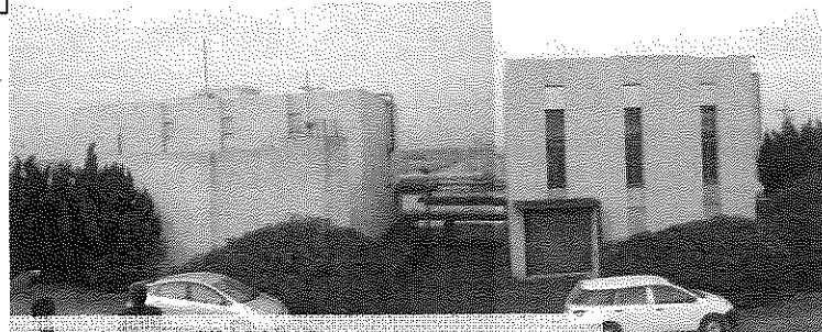
②干拓地の維持管理 (排水機場内設備修繕：ポンプ取替)
