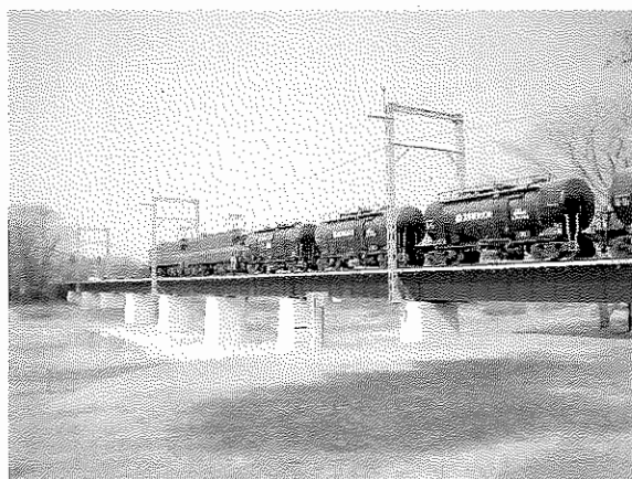
【同橋梁修繕後】
