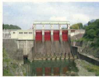
三瀬谷発電所
