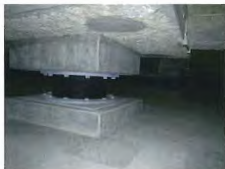
フロア内に水溜り等がなく、小動物の糞、巣がなければ良とする。
