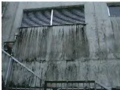
ガラリに通気不良となる障害はない状態
