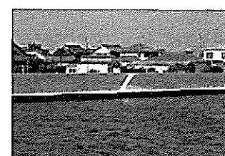
漁港海岸堤防の防災対策
