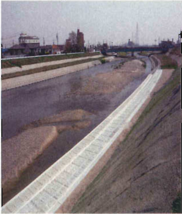
三滝川広域河川改修事業 (四日市市西町)
