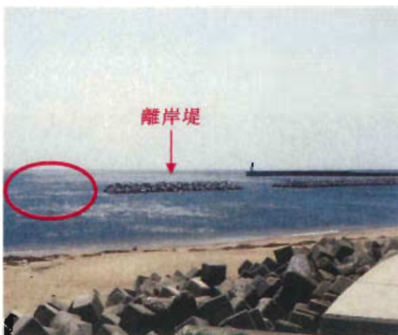
磯津地区海岸（四日市市磯津町） 平成 25 年度高潮対策着手箇所
