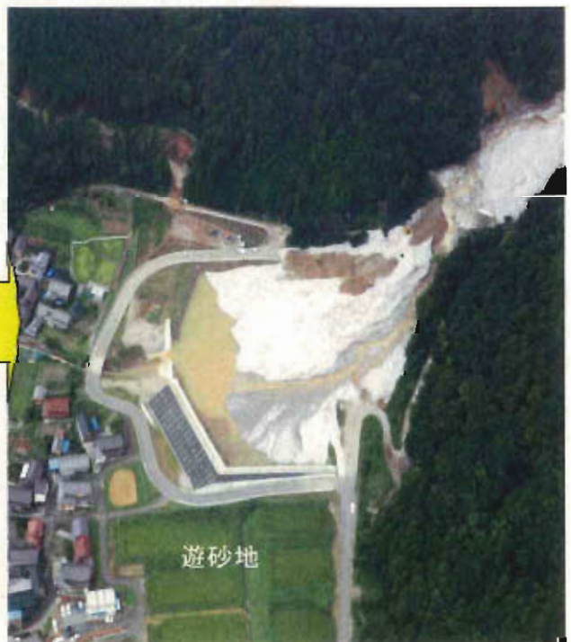
(土石流発生後)
