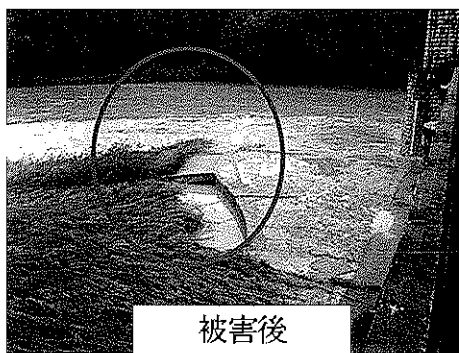
写真4 三瀬谷発電所 逆調整池ダム (魚道ゲート駆動装置破損)
