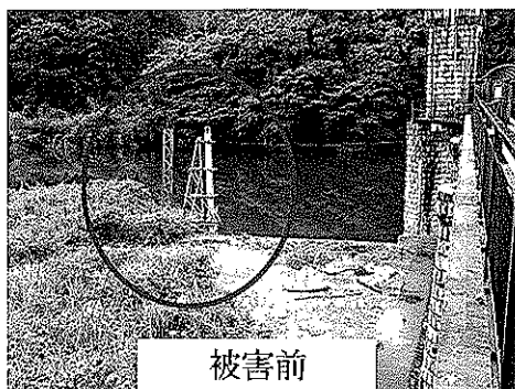
写真3 長発電所 滝原取水口 (水位計流失)
