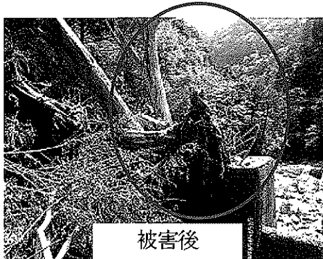
写真2 宮川第三発電所 堂倉谷取水口 (排砂用ゲート駆動装置破損)
