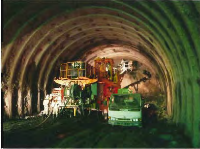
国道167号第二伊勢道路 道路改築事業 (2号トンネル堅神工区：鳥羽市堅神町)
