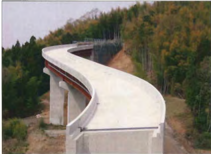
国道422号三田坂バイパス 道路改築事業 (7号橋梁：伊賀市三田)
