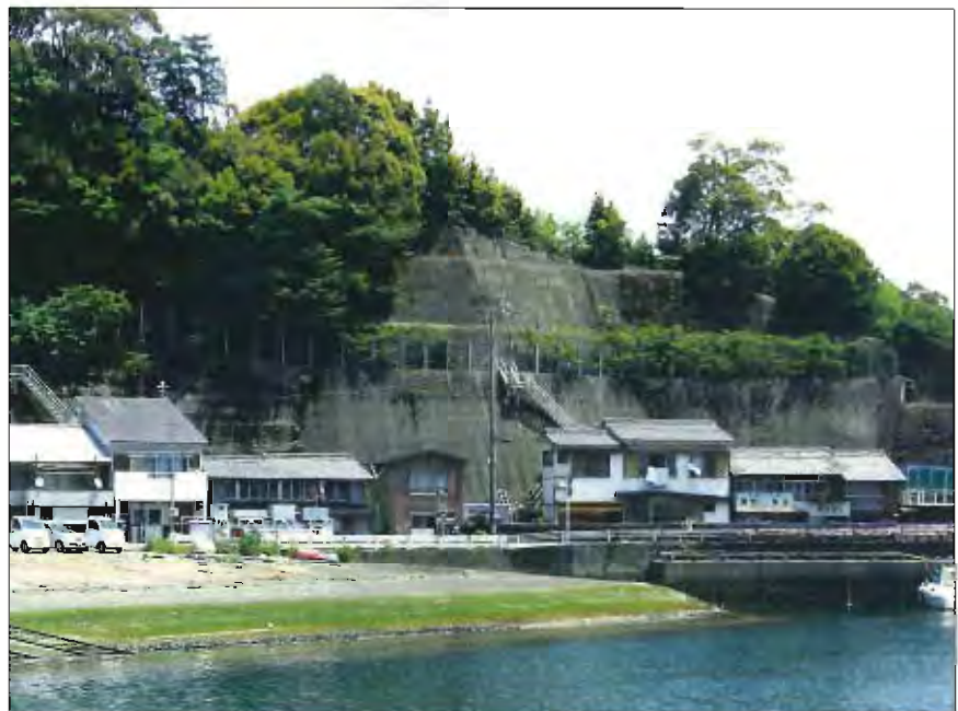
天満地区急傾斜地崩壊対策事業（尾鷲市天満）
