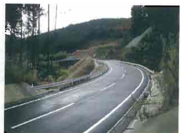
付替県道青山美杉線 (平成22年2月10日 一部供用開始)
