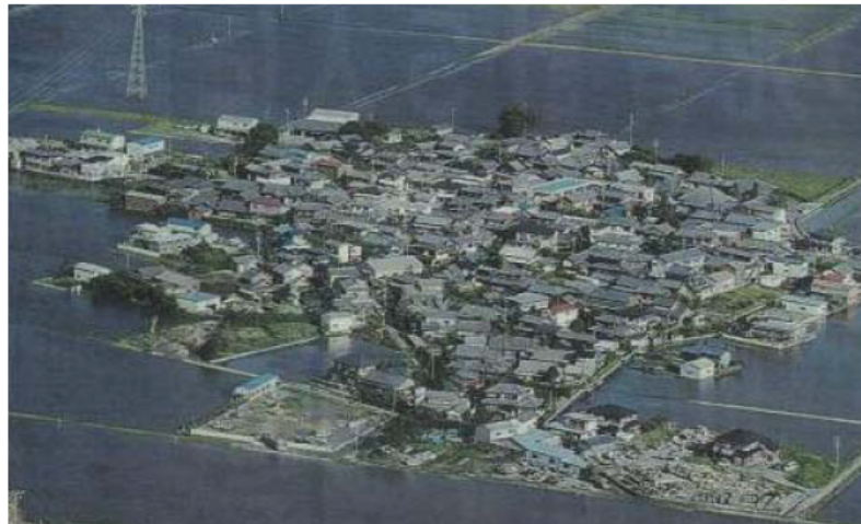
写真 2-2(2) : 平成 16 年 (2004) 台風 21 号・内水被害 (津屋城地内)
