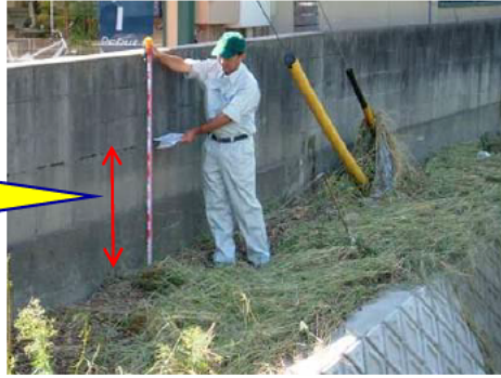
写真 2-2(1) : 平成 16 年 (2004) 台風 21 号・百々川の越水状況
