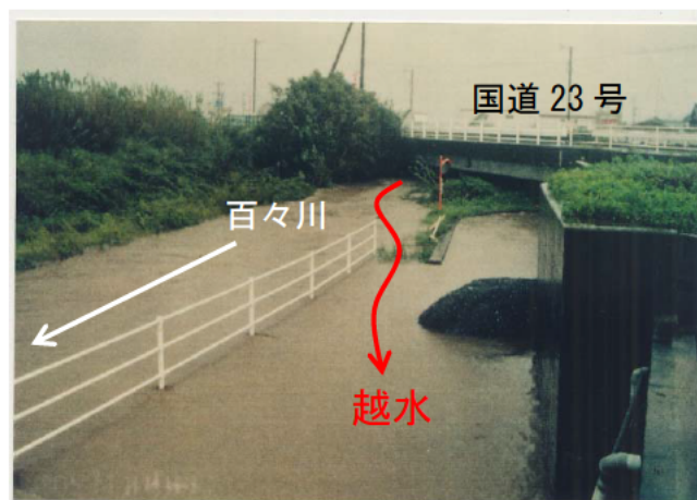
写真 2-1(2) : 平成5年11月洪水による百々川の越水状況 (国道23号付近 (河口より約900m付近) )
