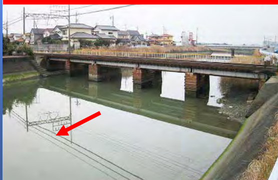
堀切川(近鉄橋梁)
