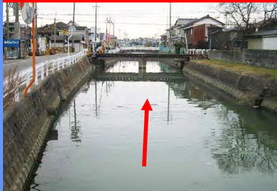
釜屋川(釜屋橋上流)
