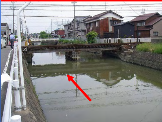
釜屋川(近鉄橋梁)
