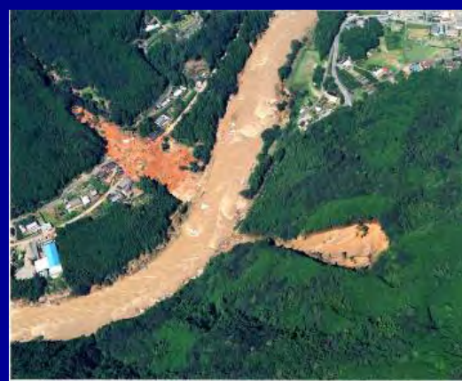
滝谷地区斜面崩壊
