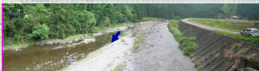
寺浦橋上流 (コンクリート護岸(左岸)、山付部(右岸))
