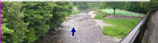
寺浦橋上流 (コンクリート護岸(左岸)、山付部(右岸))
