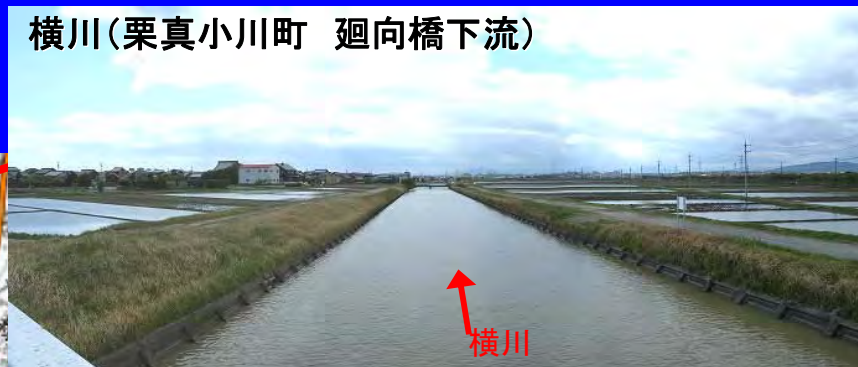
横川(近鉄名古屋線橋梁)
