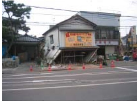
木造建築物の被害状況
