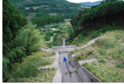
②堰堤上部から下流を望む
