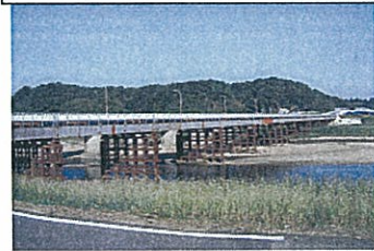
写真③ 仮橋の状況（現在供用中）
