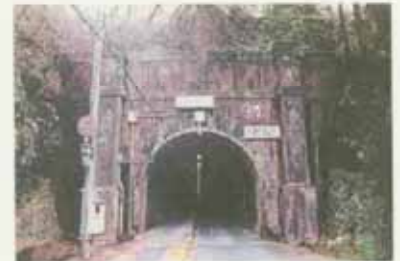
0021鬼ヶ城歩道トンネル
