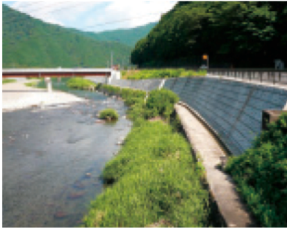
河川・護岸工事（大紀町）
