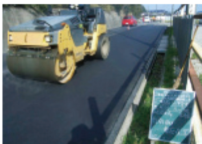
再生アスファルト合材を用いた道路舗装 【鈴鹿建設事務所】（鈴鹿市）
