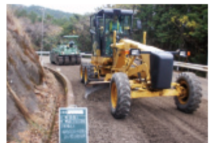
再生砕石（RC-40）を路盤材として利用 【尾鷲建設事務所】（尾鷲市）
