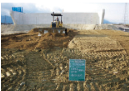
建設発生土の工事間流用 【四日市建設事務所】（四日市市）
