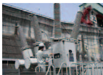
変電設備の点検
