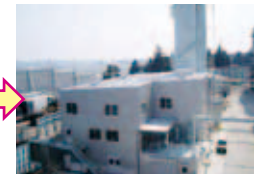
セメント資源化施設
