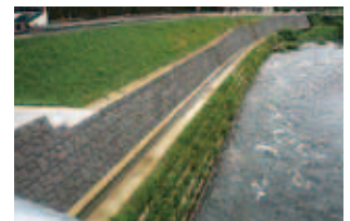
河川・護岸工事(大紀町)
