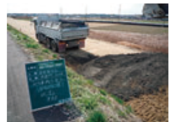
建設発生土の工事間流用 桑名建設事務所（いなべ市）
