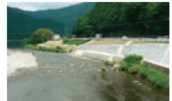
河川・護岸工事（大紀町）
