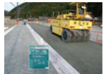
再生砕石（RC-40）を路盤材として利用 松阪建設事務所（松阪市）
