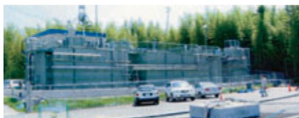
行政代執行による支障等の除去 (有害な産業廃棄物に起因する地下水の浄化施設)
