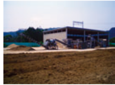
グラウンド改良材の製造（高野浄水場）
