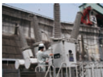
変電設備の点検
