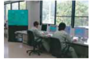
運転監視 (三瀬谷ダム・大台町)
