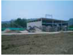
グラウンド改良材の製造(高野浄水場・津市)
