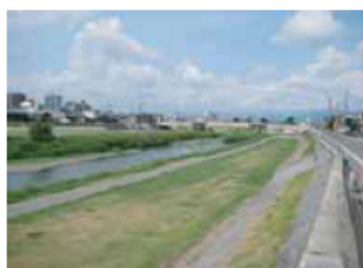
河川：護岸工事 (四日市市三滝川)
