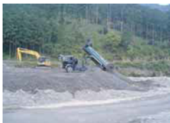
建設発生土の工事間流用 尾鷲建設事務所（紀北町）
