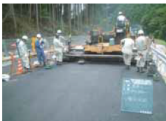
再生アスファルトを用いた道路舗装 津建設事務所（津市）
