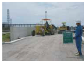
再生砕石（RC-40）を路盤材として利用 四日市建設事務所（川越町）
