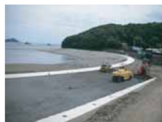
海岸：養浜工事 (南伊勢町五ヶ所港海岸 中津浜浦地区)
