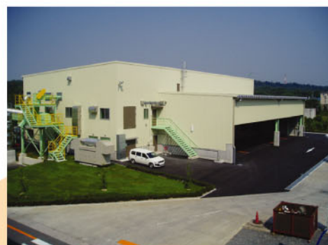
新RDF貯蔵施設(桑名市)
