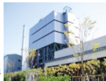
RDF発電所外観 (桑名市)
