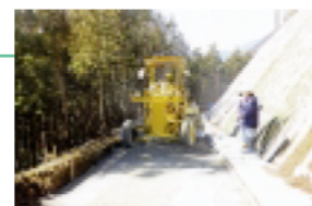
再生砕石（RC-40）を路盤材として利用 松阪地方県民局（松阪市）
