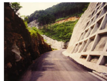
再生アスファルトを用いた道路舗装(熊野市林道浅谷越線) (紀南県民局生活環境森林部)
