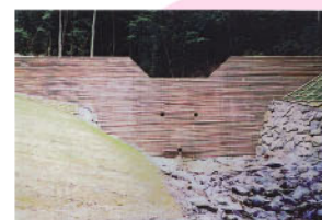
丸太残存型枠:復旧治山事業(飯高町)
