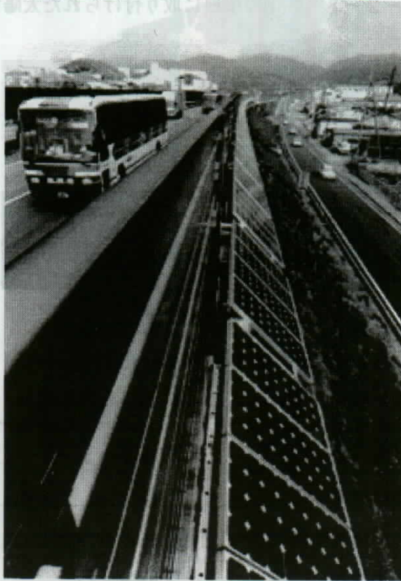
図1-2-6 国道の遮音壁にとりつけられた太陽電池 (名阪国道、天理インターチェンジ付近)
