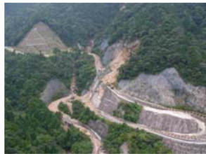
＜集中豪雨により法面崩落した 国道477号(H20)＞
