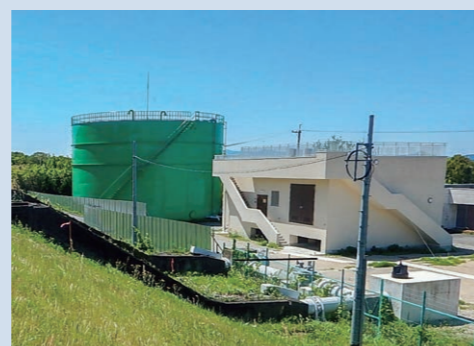
新屋敷取水所
