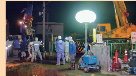
夜間の漏水復旧作業
