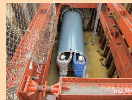
管更生工事 (PIP工法)
