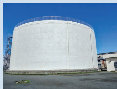
高茶屋配水池
