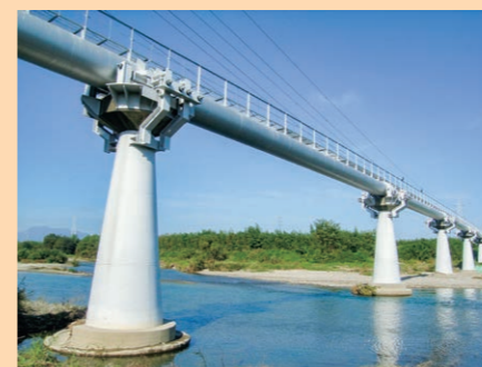
耐震補強後の水管橋
