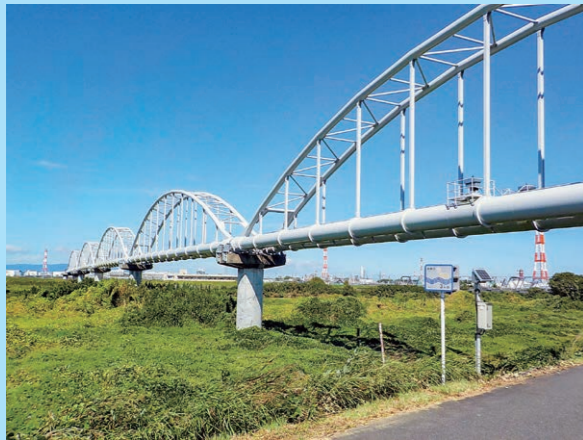
鈴鹿川第2水管橋
