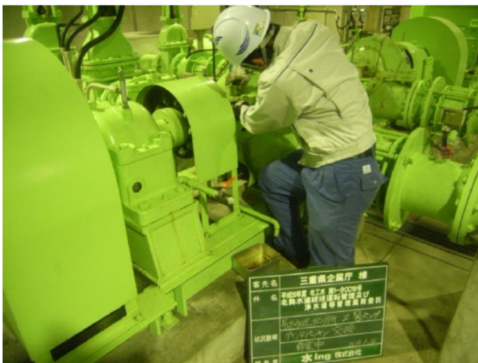
日常保守管理(ポンプ グランドパッキン交換)
