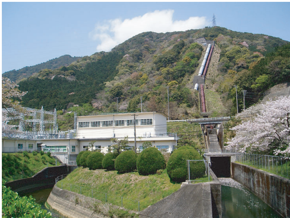
宮川第二発電所（水路式）
