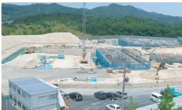
浄水場の建設 (伊賀水道用水供給事業「ゆめが丘浄水場」)
