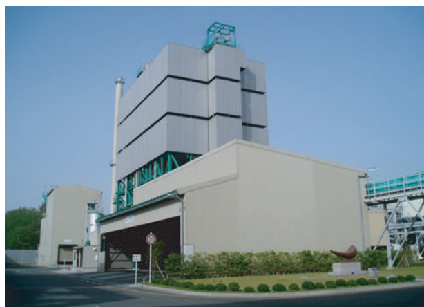
三重ごみ固形燃料発電所
