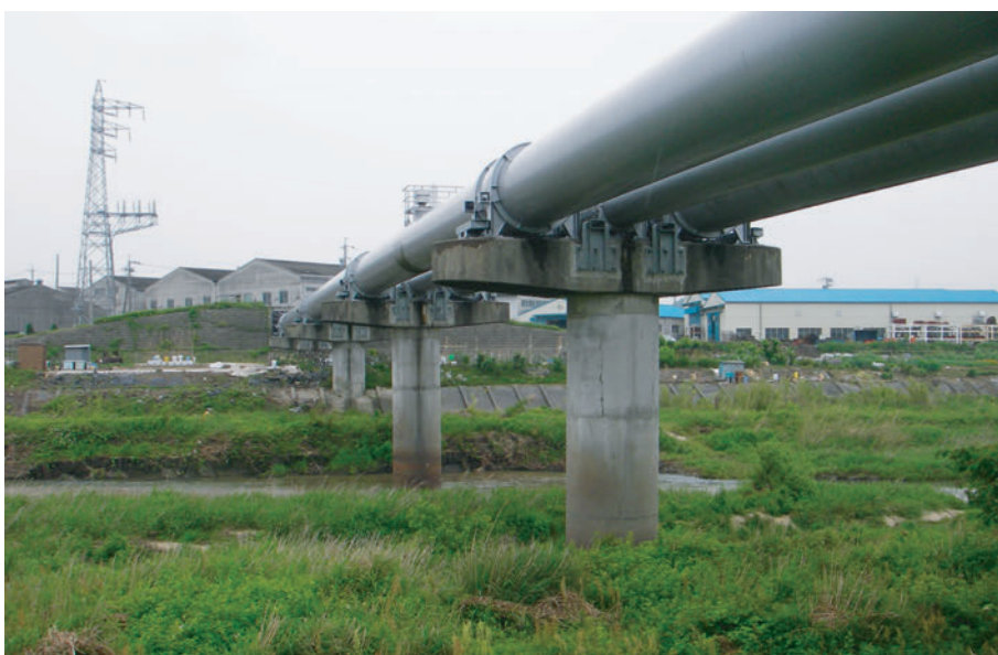
耐震補強後の朝明川水管橋
