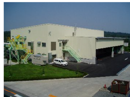
RDF貯蔵施設
