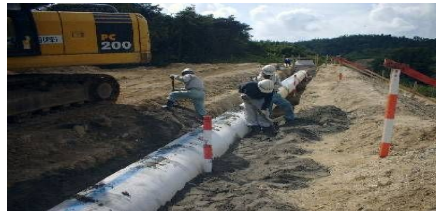
送水管布設工事（北中勢水道第2次拡張事業）
