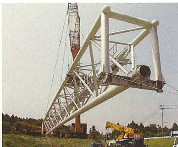
水管橋建設工事(北中勢水道第2次拡張事業)
