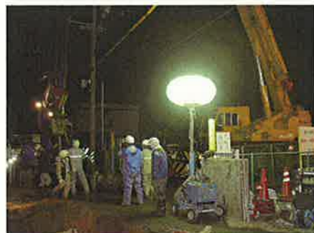
夜間の漏水復旧作業
