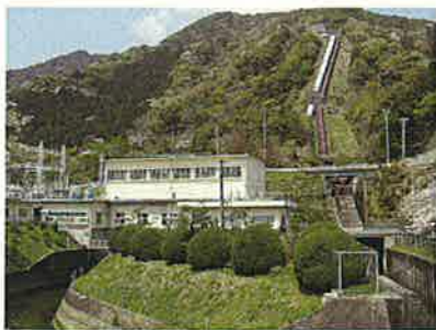
宮川第二発電所（水路式）
