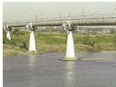
耐震補強後の員弁川水管橋
