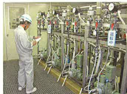
薬品注入設備の定期点検
