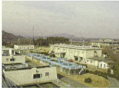
浄水場（北中勢水道 高野浄水場）
