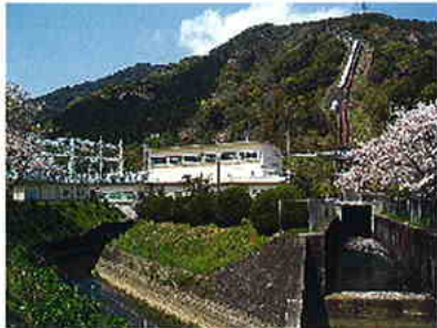
宮川第二発電所(水路式)
