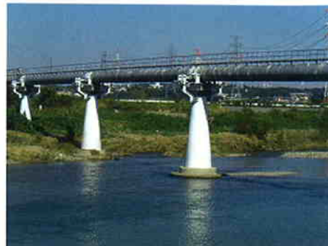
耐震補強後の員弁川水管橋
