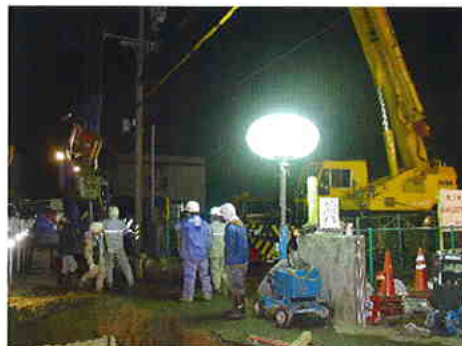
夜間の漏水復旧作業
