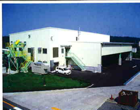
RDF貯蔵施設
