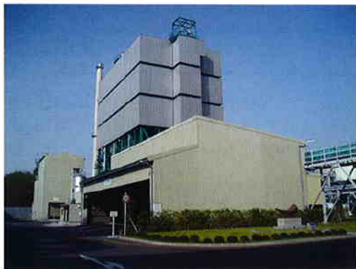
三重ごみ固形燃料発電所
