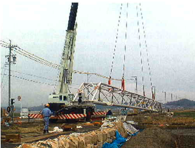
水管橋建設工事(伊賀水道建設事業)
