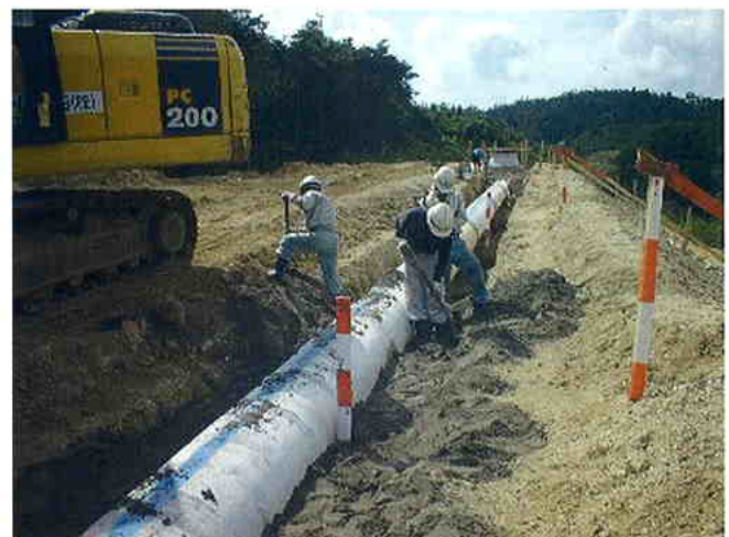
送水管布設工事(北中勢水道第2次拡張事業)
