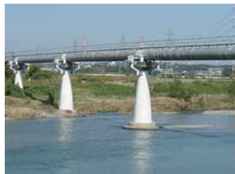
耐震補強後の員弁川水管橋
