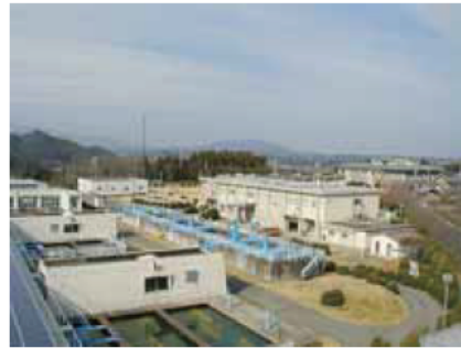
浄水場(北中勢水道 高野浄水場)
