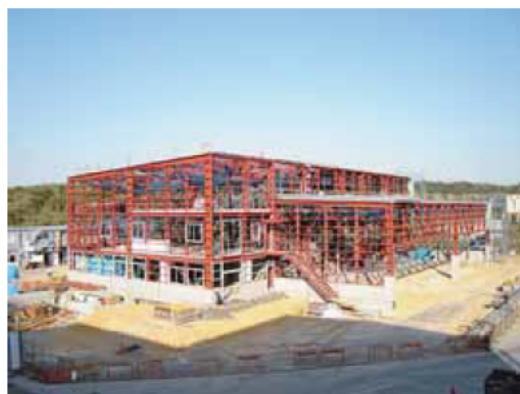
建設中のRDF貯蔵施設
