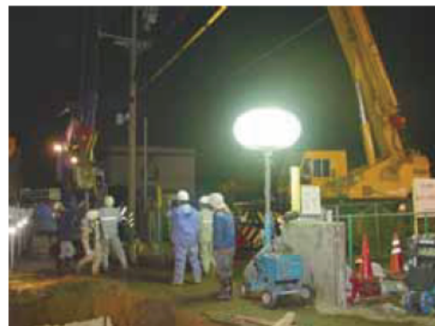
夜間の漏水復旧作業
