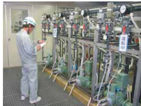
薬品注入設備の定期点検
