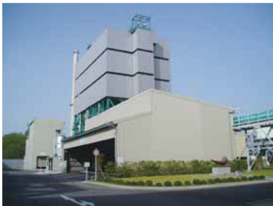
三重ごみ固形燃料発電所
