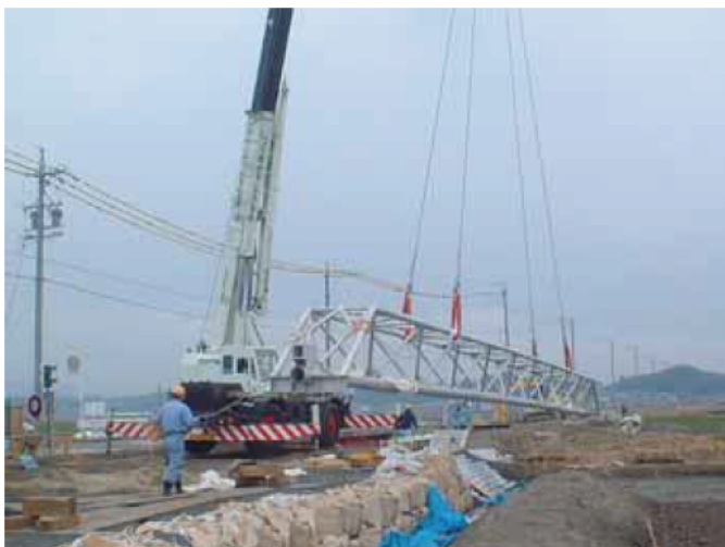
水管橋建設工事(伊賀水道建設事業)
