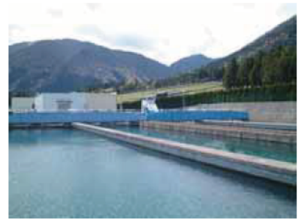
沈でん池(北中勢水道 水沢浄水場)
