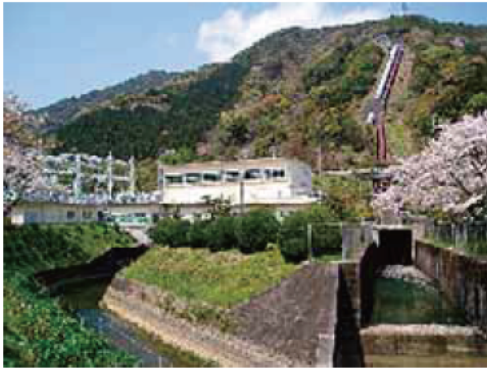
宮川第二発電所(水路式)
