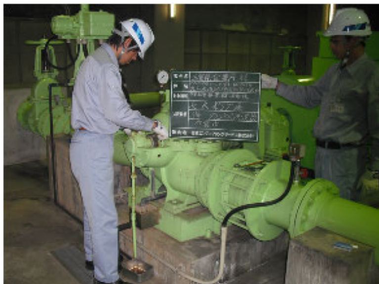
修繕作業(ポンプ グランドパッキン交換)
