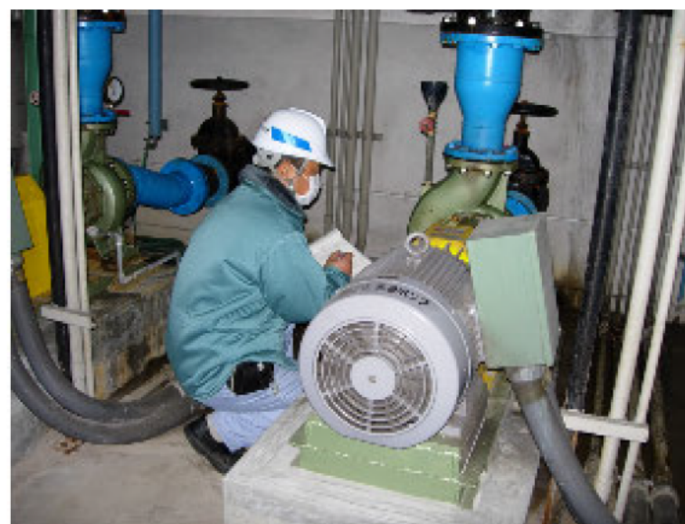
施設巡視点検
