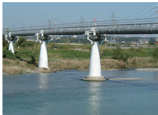
耐震補強後の水管橋
