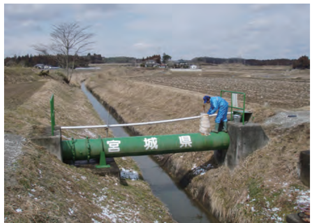
【工業用水道施設・管路の点検】
