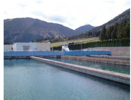
沈でん池（北中勢水道 水沢浄水場）
