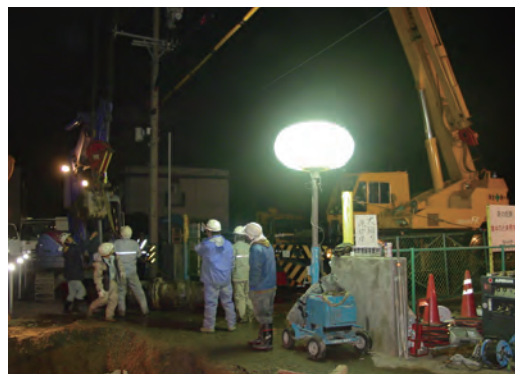
夜間の漏水復旧作業
