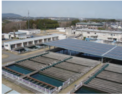
浄水場（北中勢水道 高野浄水場）
