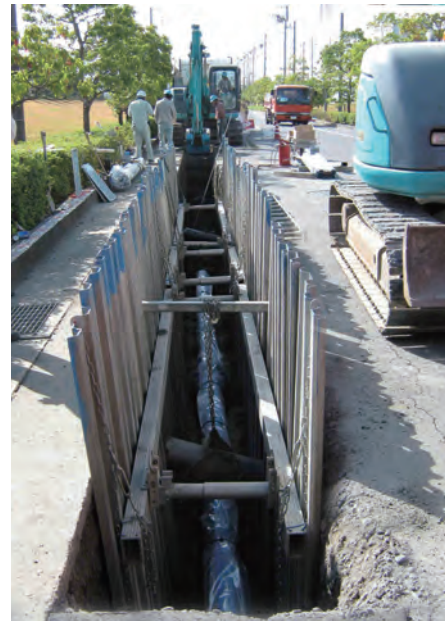
【送水管布設工事(イメージ写真)】
