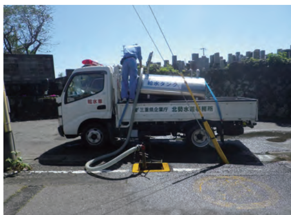
【給水車への補給作業(紀宝町)】
