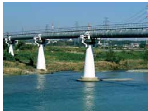
耐震補強後の員弁川水管橋
