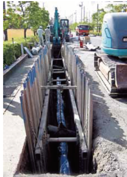
送水管布設工事(イメージ写真)
