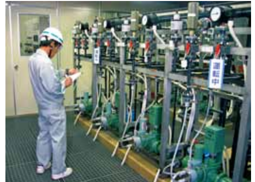
薬品注入設備の定期点検
