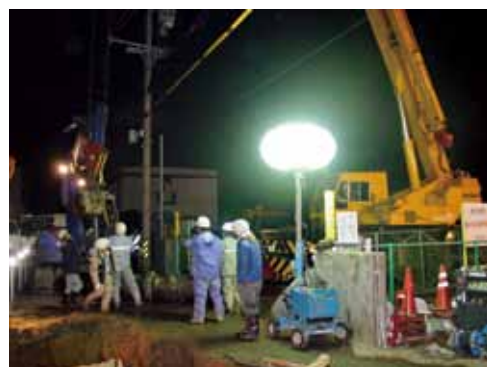
夜間の漏水復旧作業
