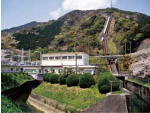
宮川第二発電所(水路式)
