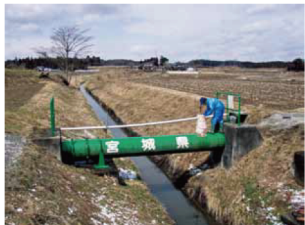
【工業用水道施設・管路の点検】
