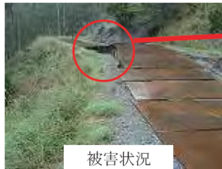
青田発電所 導水路（導水路損傷）
