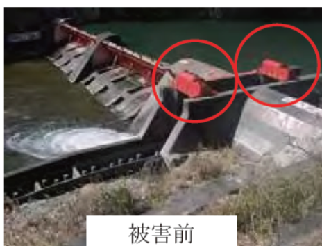
三瀬谷発電所 逆調整池ダム（魚道ゲート駆動装置破損）
