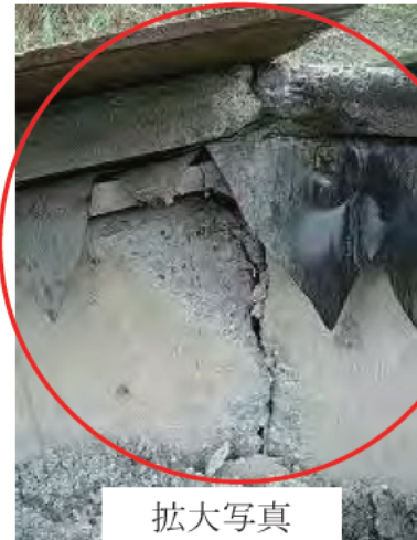
青田発電所 導水路（導水路損傷）
