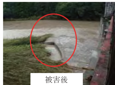
長発電所 滝原取水口（水位計流失）
