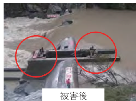
三瀬谷発電所 逆調整池ダム（魚道ゲート駆動装置破損）
