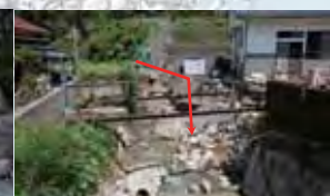
熊野市五郷町寺谷 宇桑瀬谷 溪流荒廃と山腹崩壊により、土砂が溪流を流下し、溪流に堆積。既設谷止工より下流には、土砂の流下はないが、水流により公民館の敷地一部が破損。
