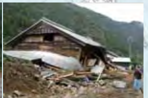
大台町岩井 宇持山谷 一級河川の支流で、山腹崩壊が発生。流出土砂が、本流を越えて、対岸の人家が被災。
