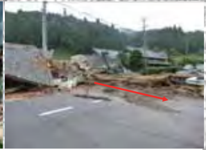
津市美杉村石名原 宇所谷 山腹崩壊(表層)による土石流が発生し、下流集落が被災。
