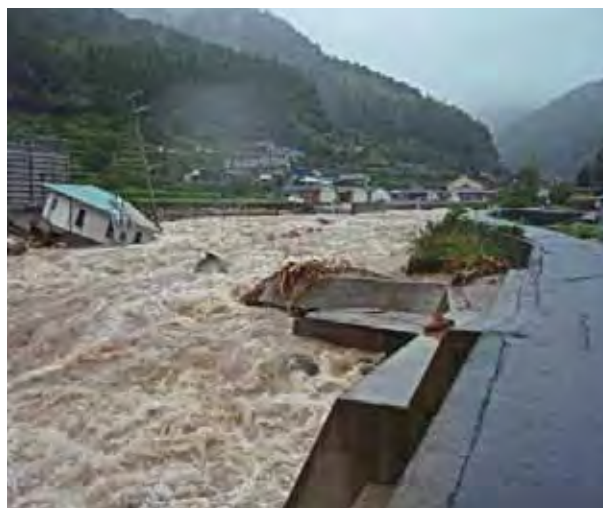
井戸川の護岸決壊（熊野市井戸町）
