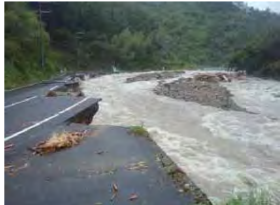
道路の流出(熊野市井戸)
