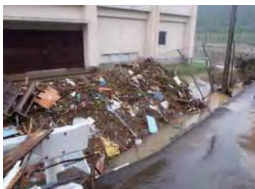
県立紀南高校の被害
