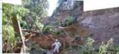
御浜町大字上市木 宇明神滝 山腹崩壊が発生し、熊野古道が被災。土砂は下方に堆積。
