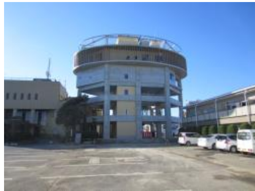
津波避難ビル（防災拠点施設）（紀宝町）
