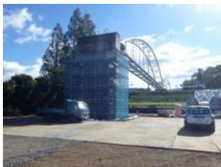
水道施設（水管橋）の耐震化（玉城町）
