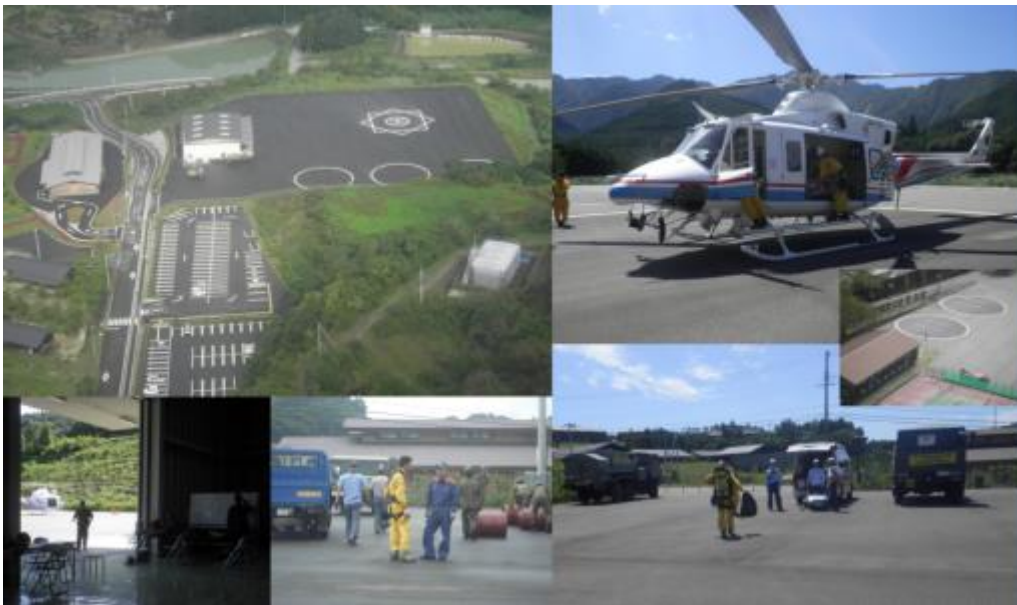
三重県広域防災拠点（東紀州拠点）
