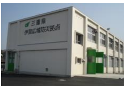
伊賀広域防災拠点
