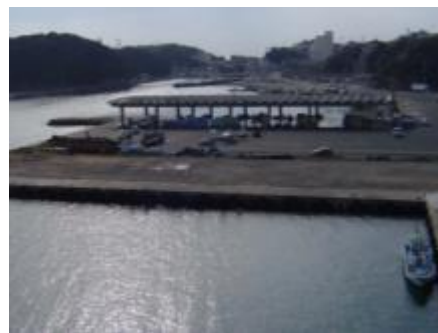
漁港での耐震強化岸壁の整備（志摩市）
