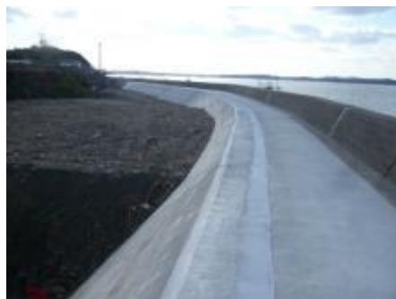
海岸堤防施設の老朽化対策（鳥羽市）
