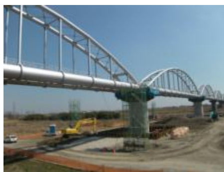
工業用水道施設（水管橋）の耐震化（四日市市）
