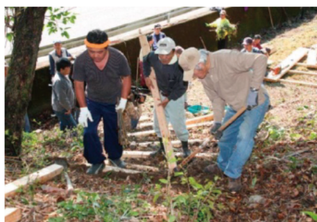
住民主体で設置した津波避難路（紀北町）
