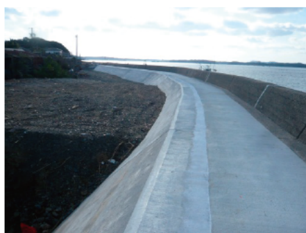
海岸堤防施設の老朽化対策（鳥羽市）
