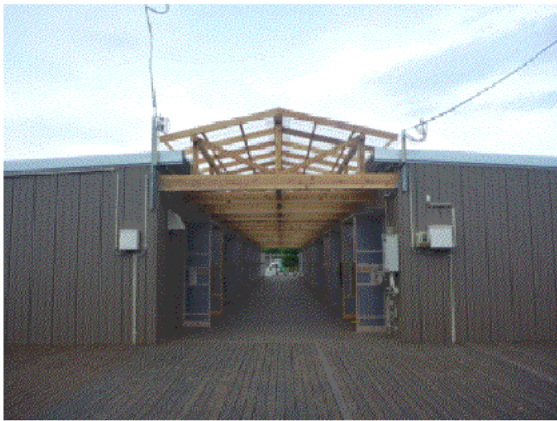
(左) ケアゾーンの仮設住宅 (正面)
