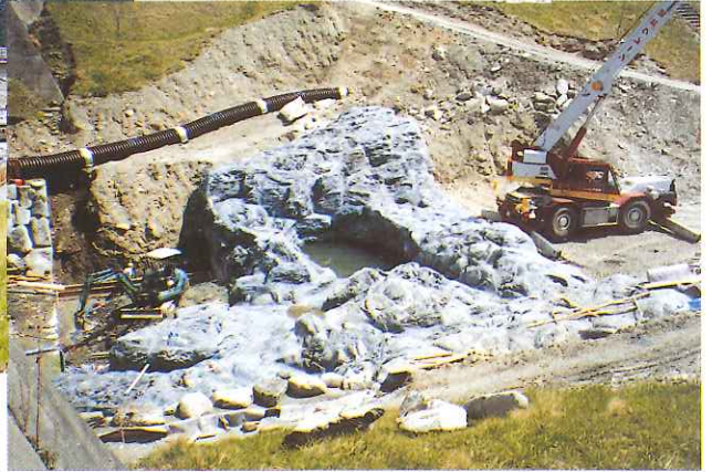
床固工の施工状況
