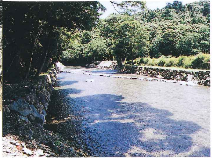
とび石と護岸工及び床固工
