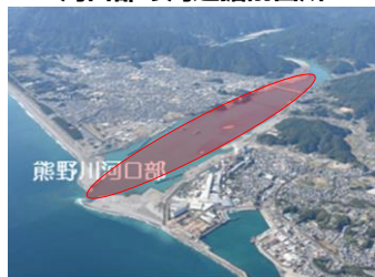
河口部の河道掘削箇所
