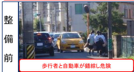
(都)服部橋新都市線(伊賀市) (R4完)
